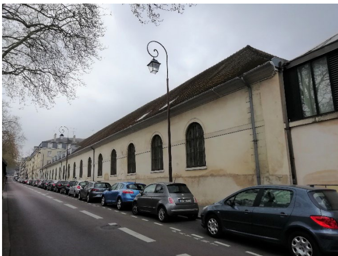
Vue de la caserne depuis la contre-allée de l'avenue de Sceaux Côté Nord
