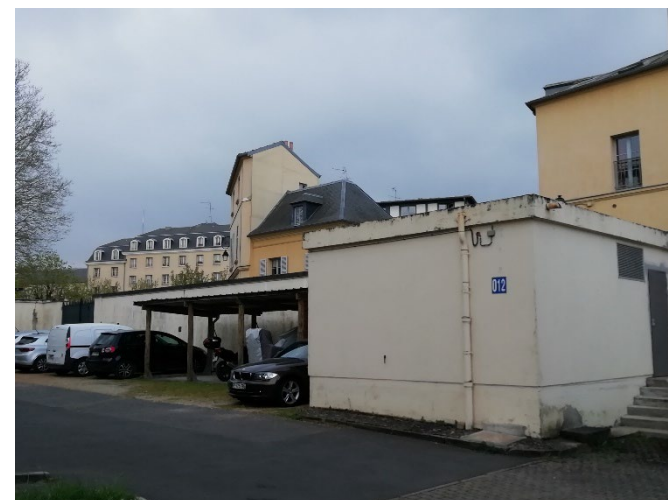
Courette comprise entre la façade sud du bâtiment Carré et le mur de clôture parallèle à la rue Saint Médéric
