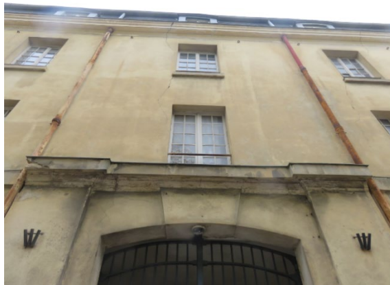
Partie de bandeau subsistant au niveau du portail central, avenue de Sceau
