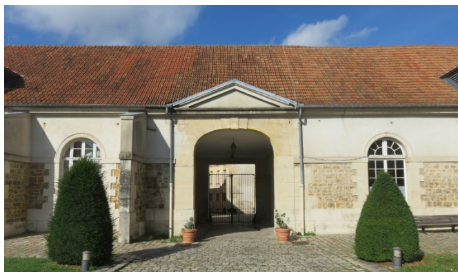
Accès à la rotonde par une baie en anse de panier coiffé d'un fronton canonique
