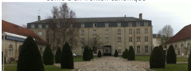
Façade ouest du pavillon carré
