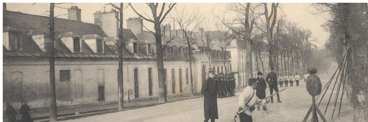
Vue depuis l'avenue de Sceaux des façades disparues qui encadraient le portail monumental conservé et classé MH en 1929 - Source : archives municipales
