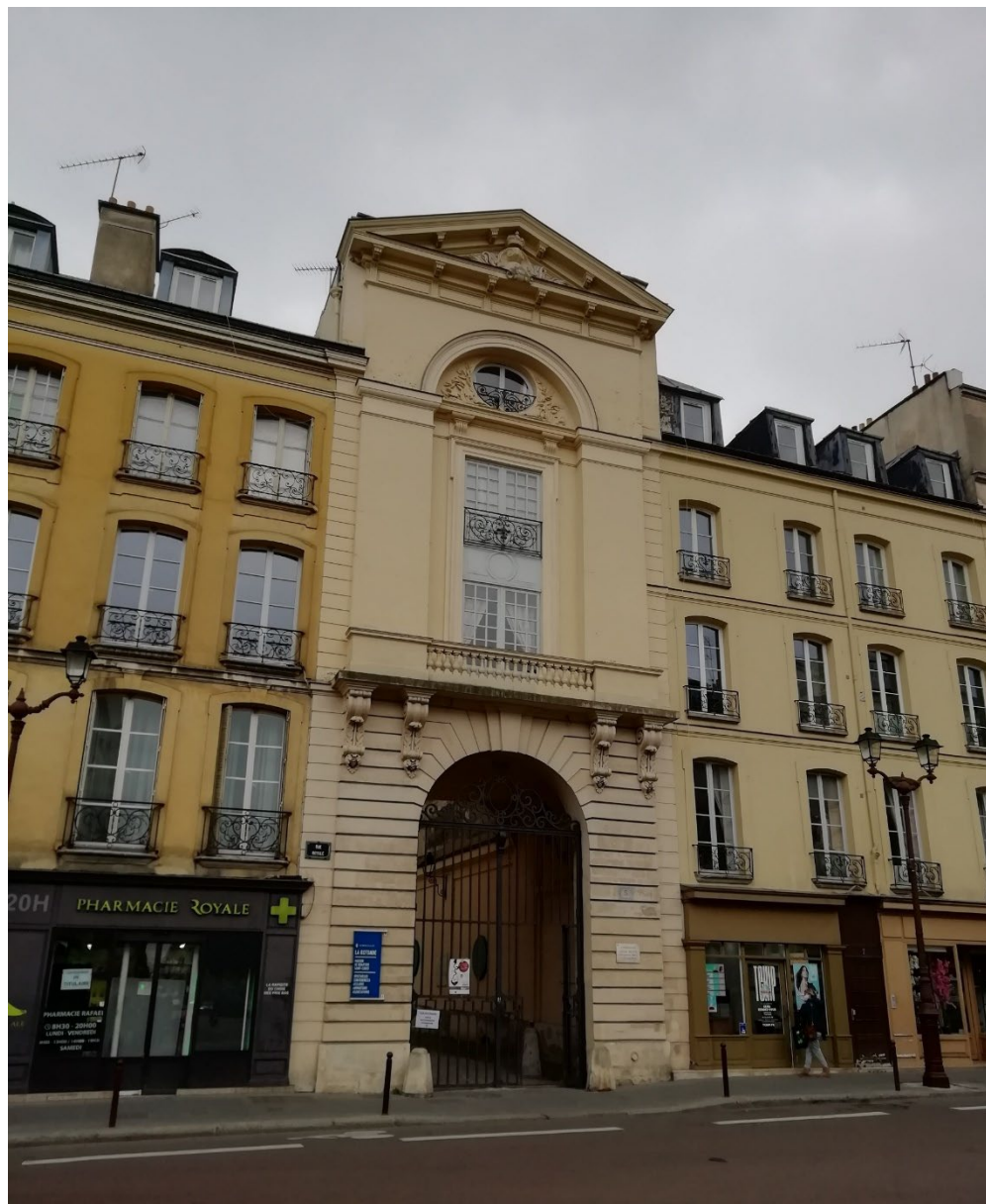
Porte Ouest rue Royale
