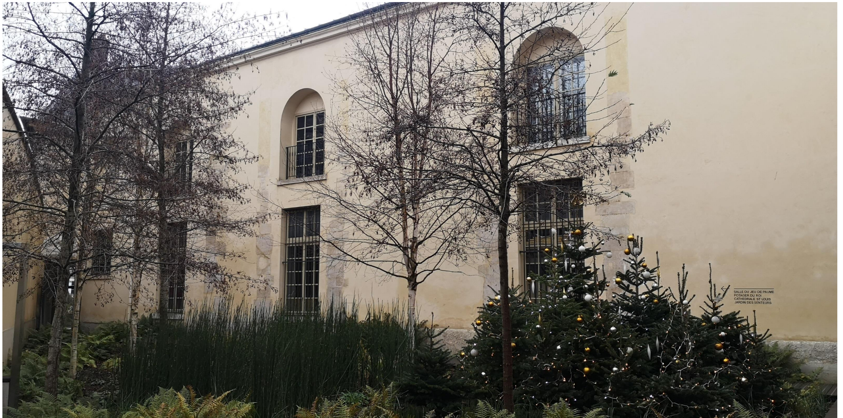
Vue de la façade Nord de la caserne depuis le jardin des Senteurs (ancienne façade des chapelles latérales de l'église démolie)
