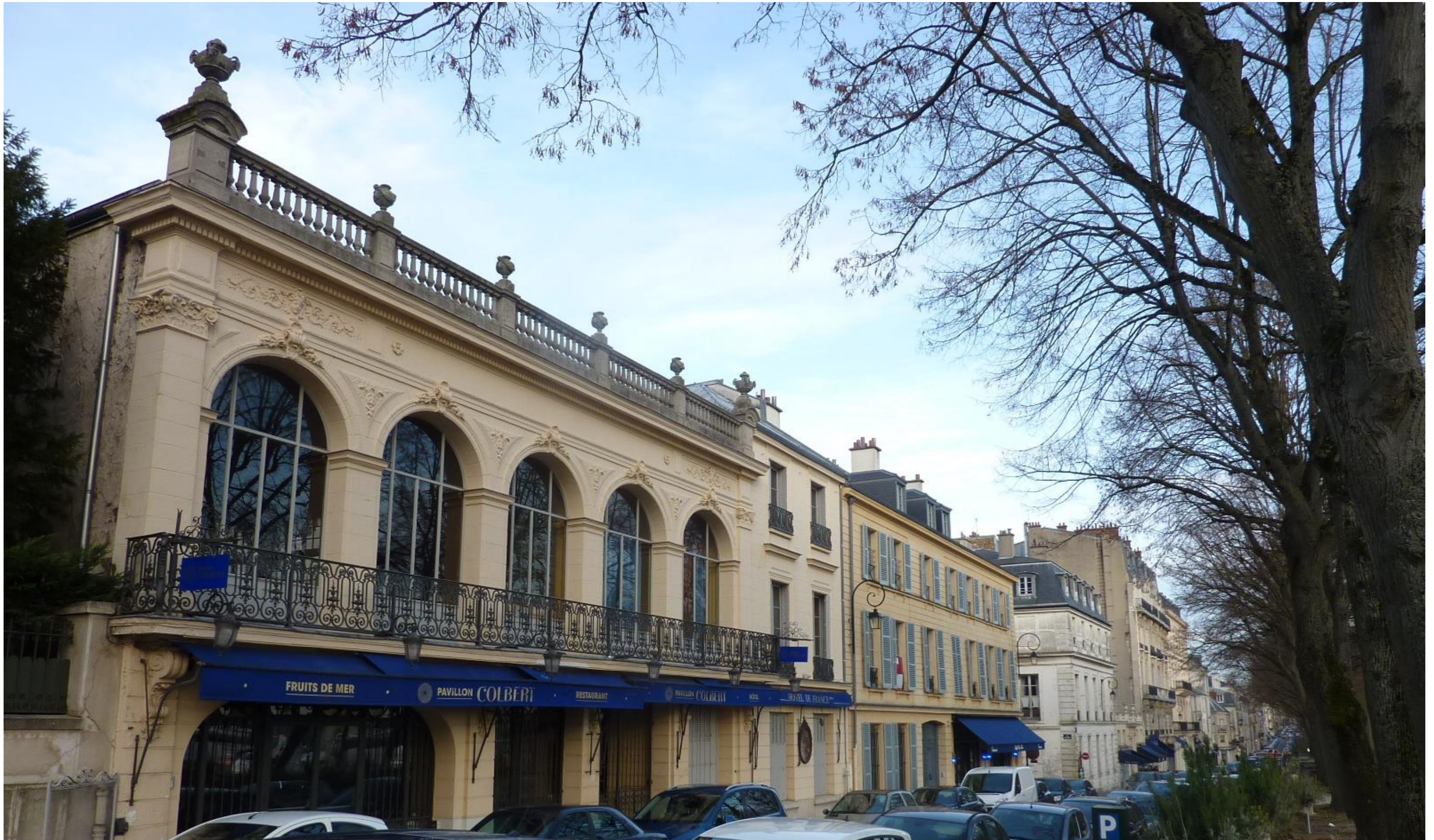
Vue de la façade du n°5 rue Colbert avec les arcades et le balcon de la salle de réception à l'étage.
