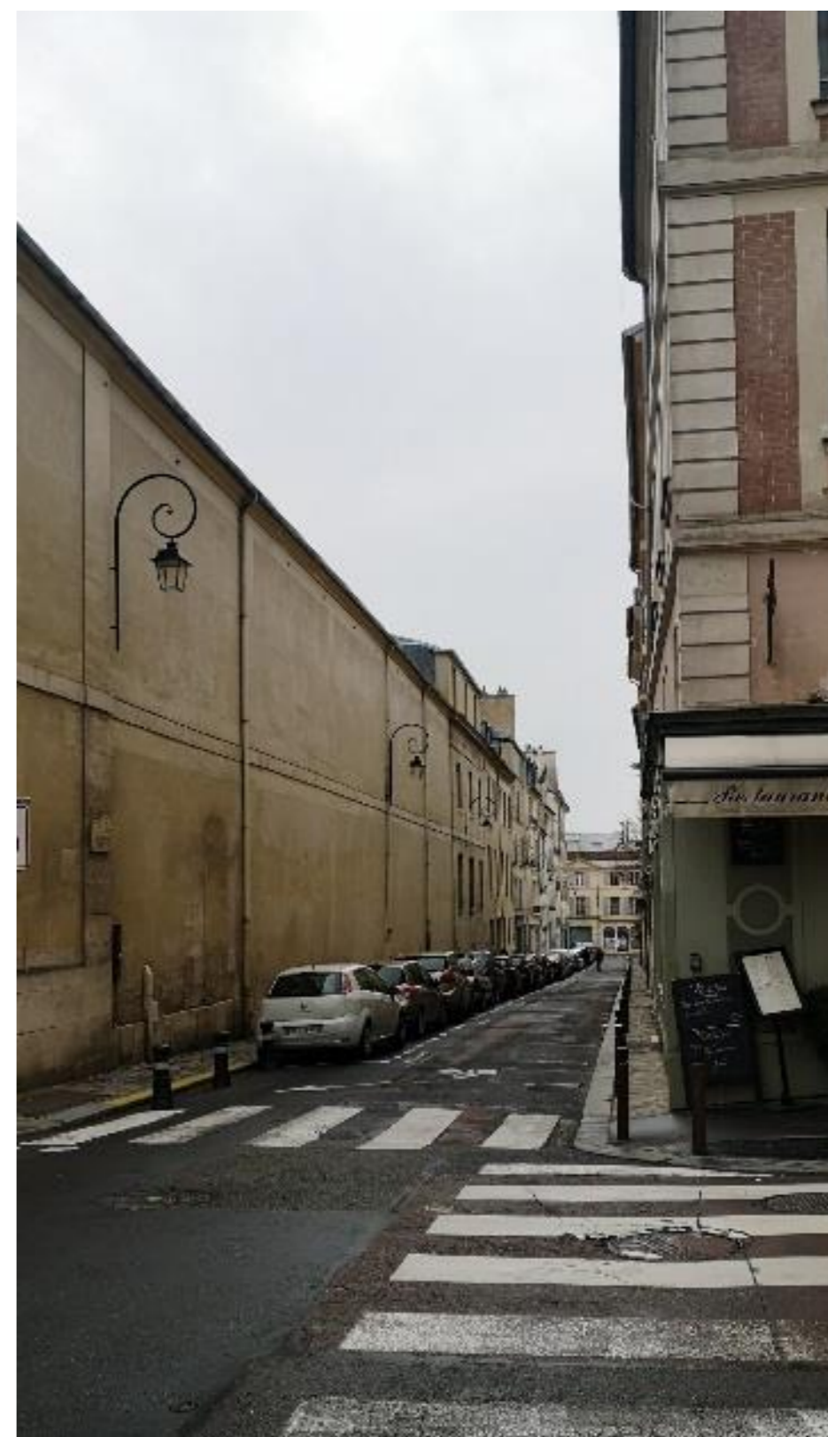
Façade ouest depuis le nord de la rue des Récollets
