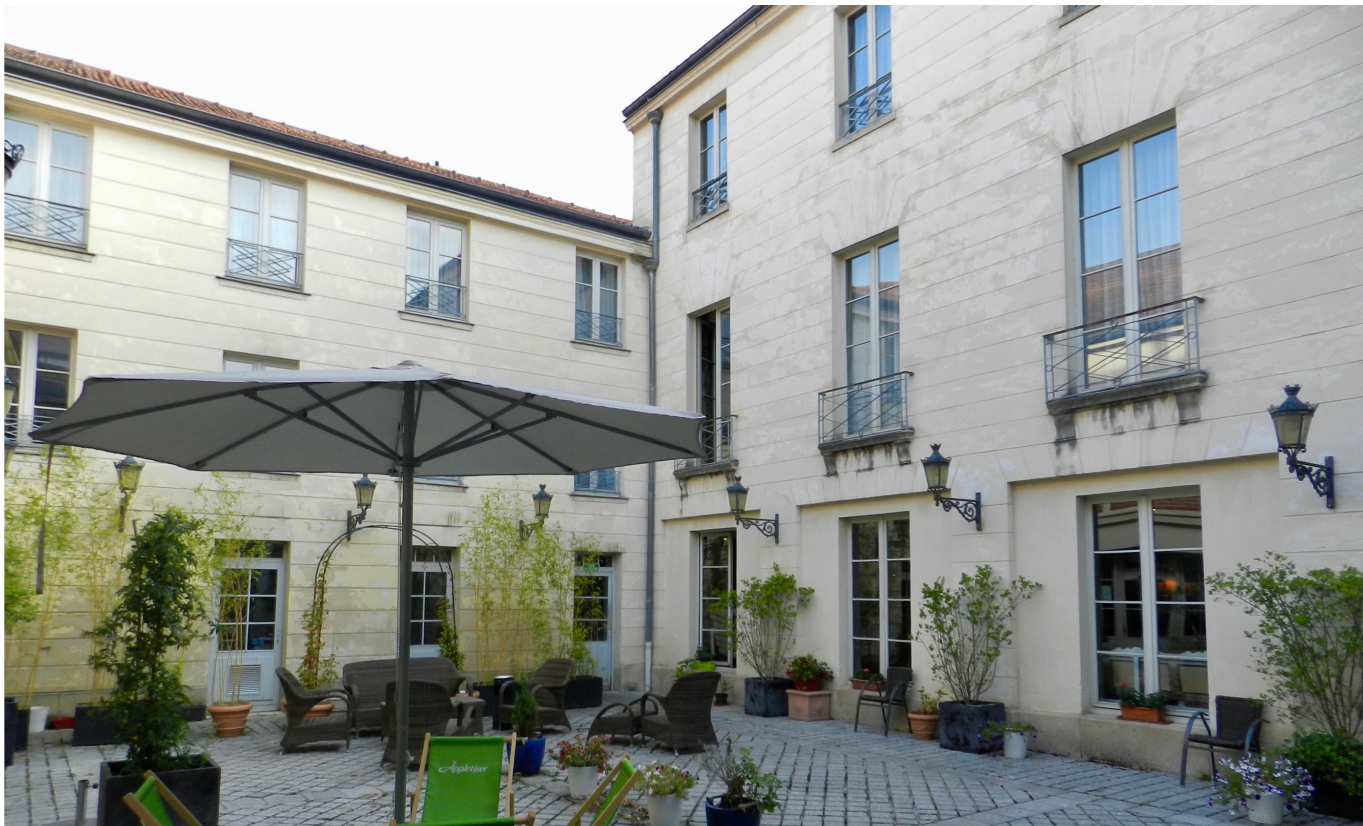
Façades Sud et Est de la seconde cour du 5, rue Colbert
