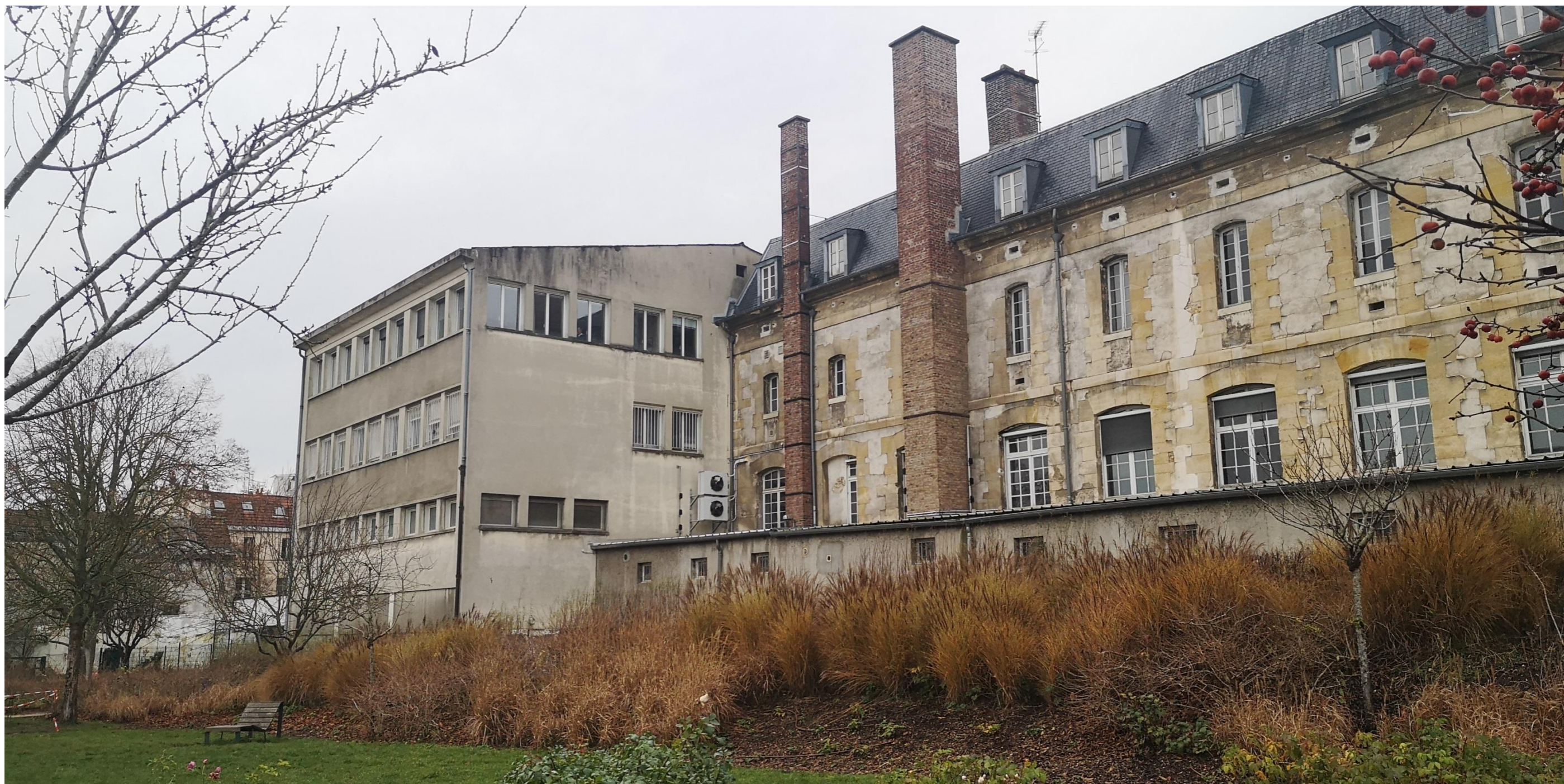
Vue de la façade Est de la caserne depuis le nord du jardin des Senteurs
