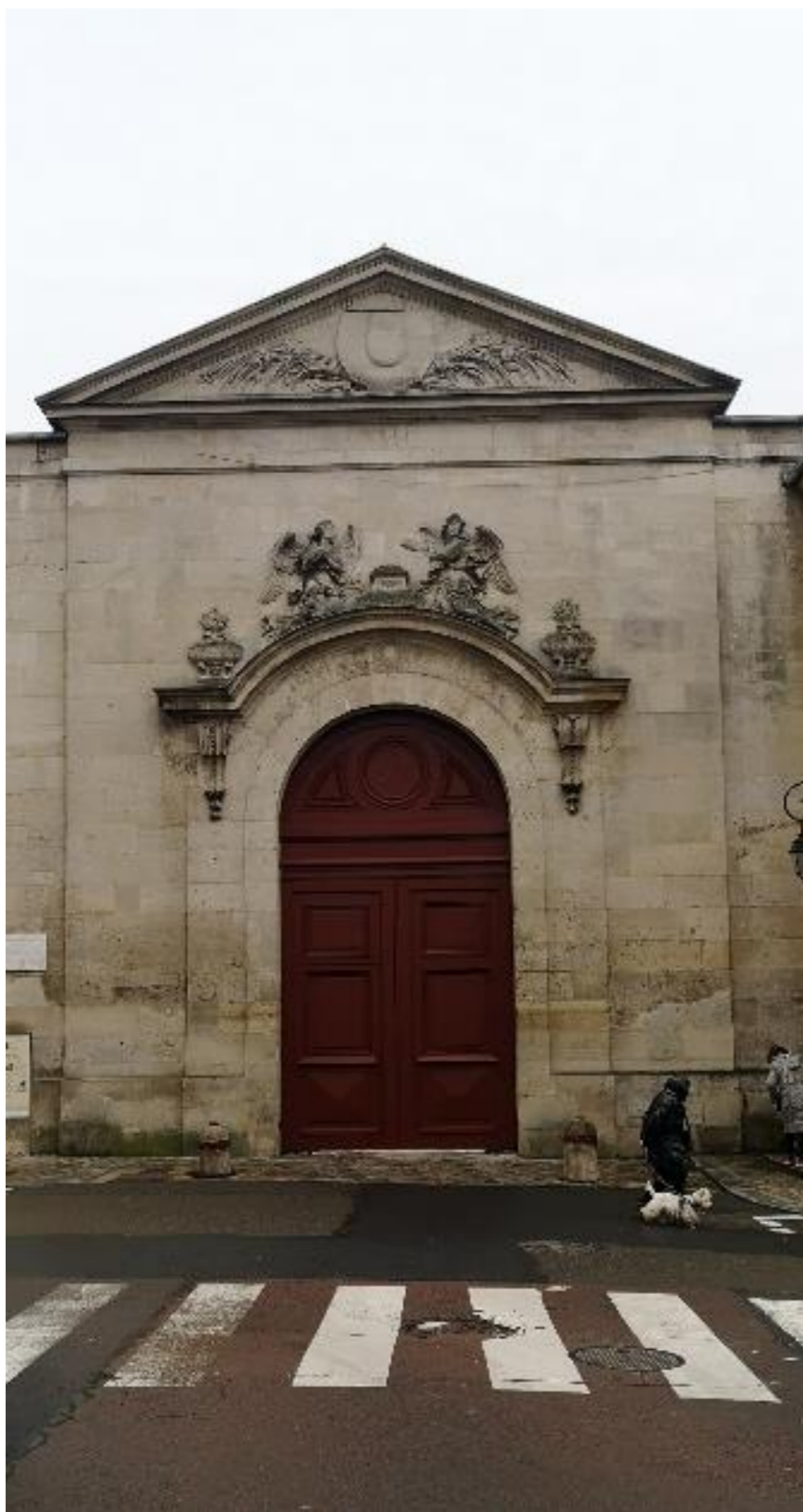
Vue du portail - rue des Récollets
