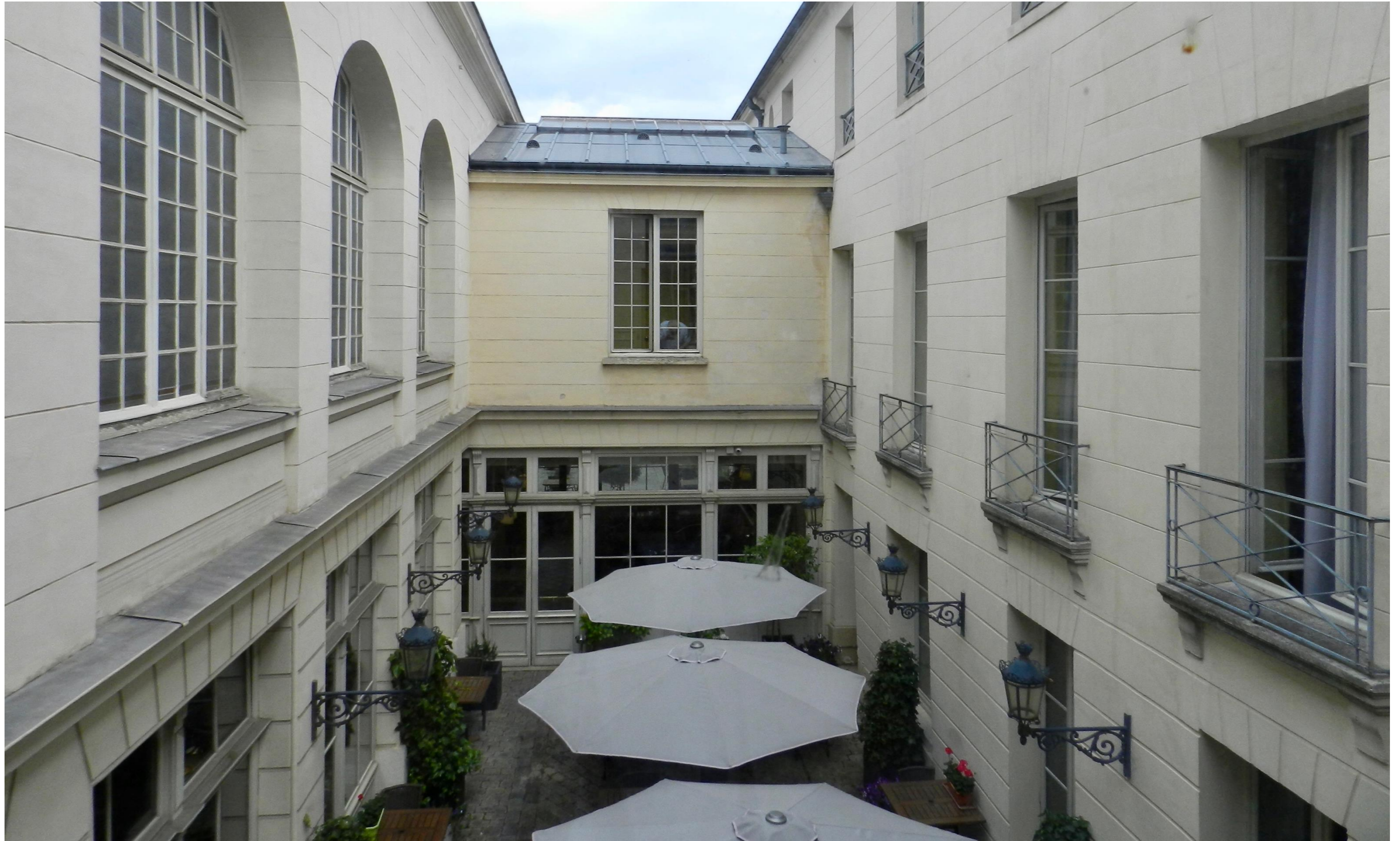
Façades Ouest, Est et Nord de la première cour du 5, rue Colbert
