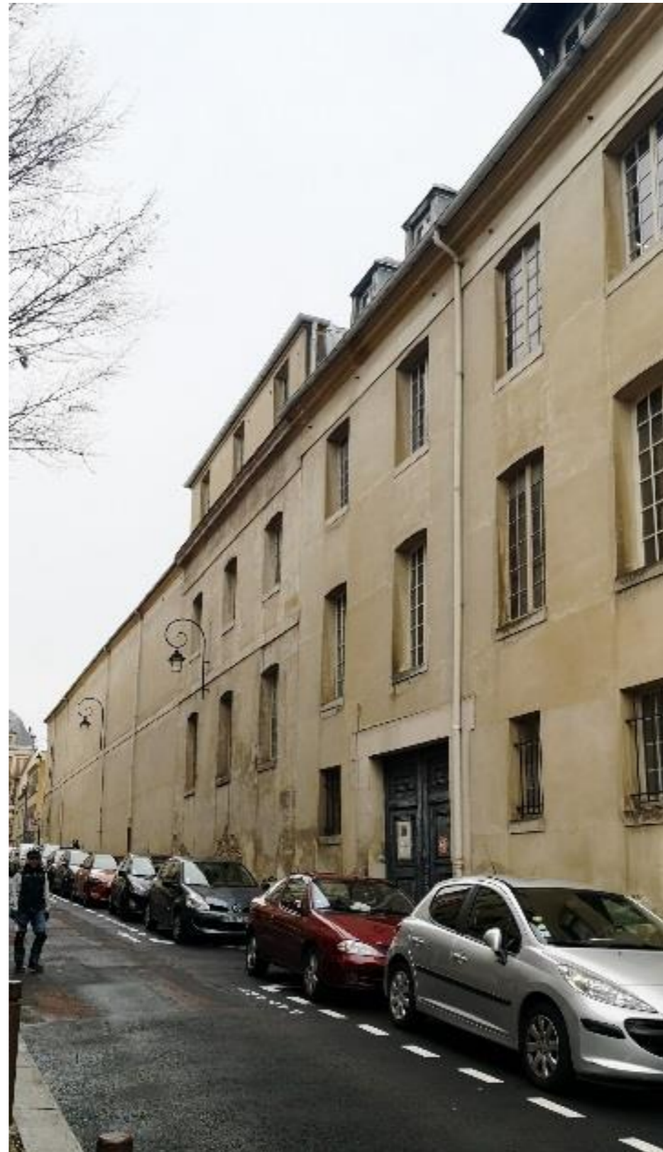
Façade Ouest depuis le sud de la rue des Récollets
